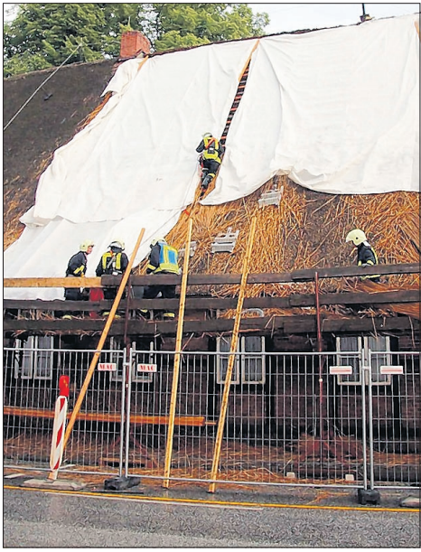
In Bargtheide griff der Sturm unter zwei Planen, mit denen das Dach der Gaststätte „Utspann“ abgedeckt war. Dort wird zur Zeit das Reetdach erneuert. Foto: JEB
